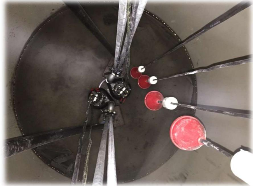
Pumpen wurden auf Kundenwunsch ausgelegt und im Pumpenschacht komplett vormontiert. Die Pumpen sind jeweils auf einer Führungsstange montiert, so dass jede Pumpe zur Wartung leicht gezogen werden kann.
